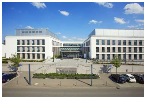
Bild: Neubau Zollernalb Klinikum Balingen
